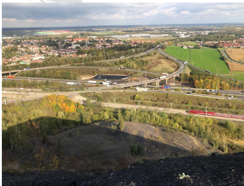
Nœud autoroutier et ferroviaire de Douges – Crédit photo : CAHC
